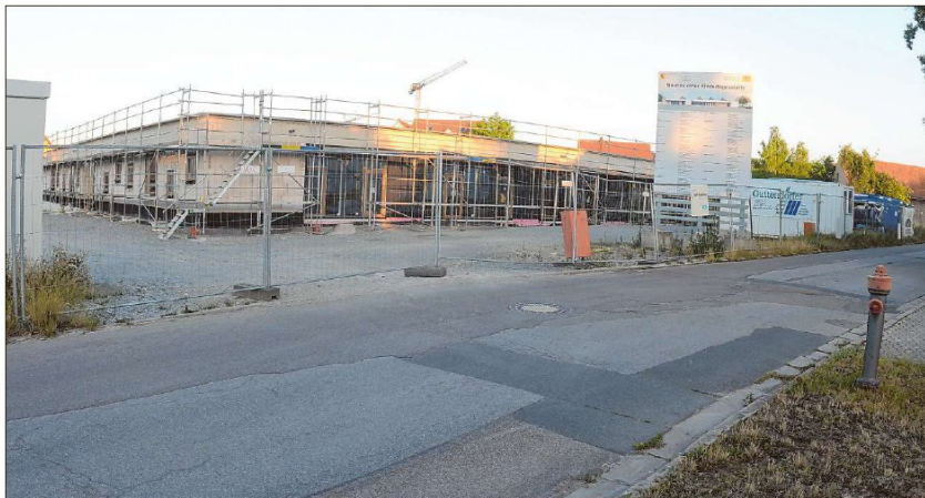
In diesem Bereich liegt die Zufahrt auf das Kita-Areal.
